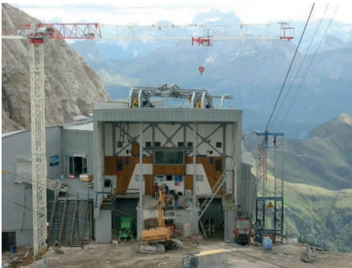
► Con i lavori di ristrutturazione del 2004, la stazione di Serauta è stata radicalmente modificata per permettere alle cabine di arrivare e partire sullo stesso piano. Una gru Comedil Terex ritorna in quota.
