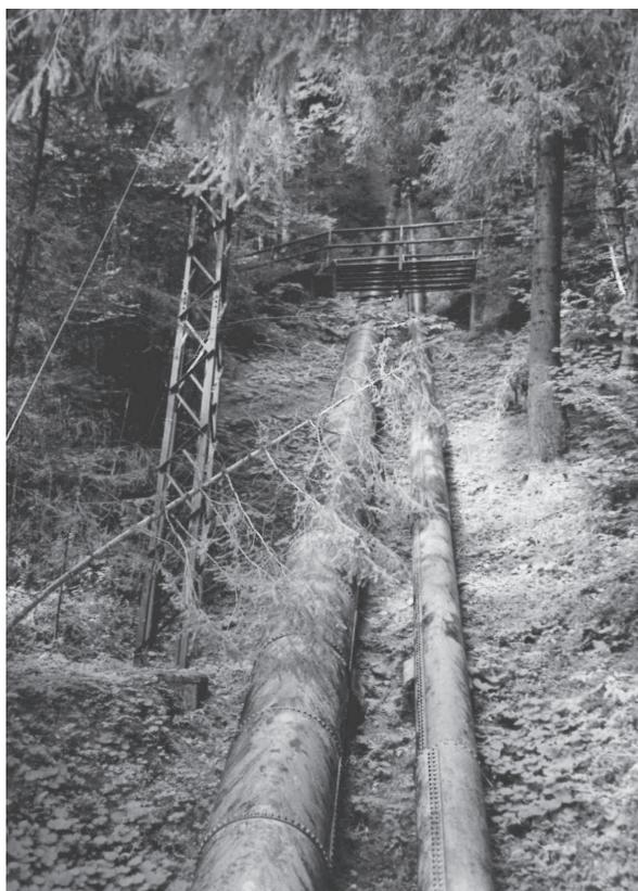
◀ Fotografia della vecchia condotta della prima centrale idroelettrica di Calalzo
