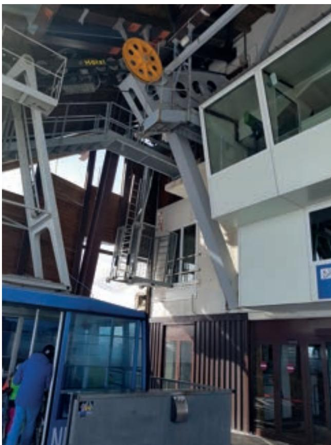
▲ Il nuovo sistema di sostegno della scarpa di arrivo delle portanti oggi sostenuto da una struttura in acciaio appositamente realizzata. Questo intervento ha permesso di ridurre il carico sui vecchi portali in acciaio che ora reggono solo la copertura, mentre il carico dei meccanismi funiviari è portato da una nuova struttura in acciaio appositamente realizzata.
